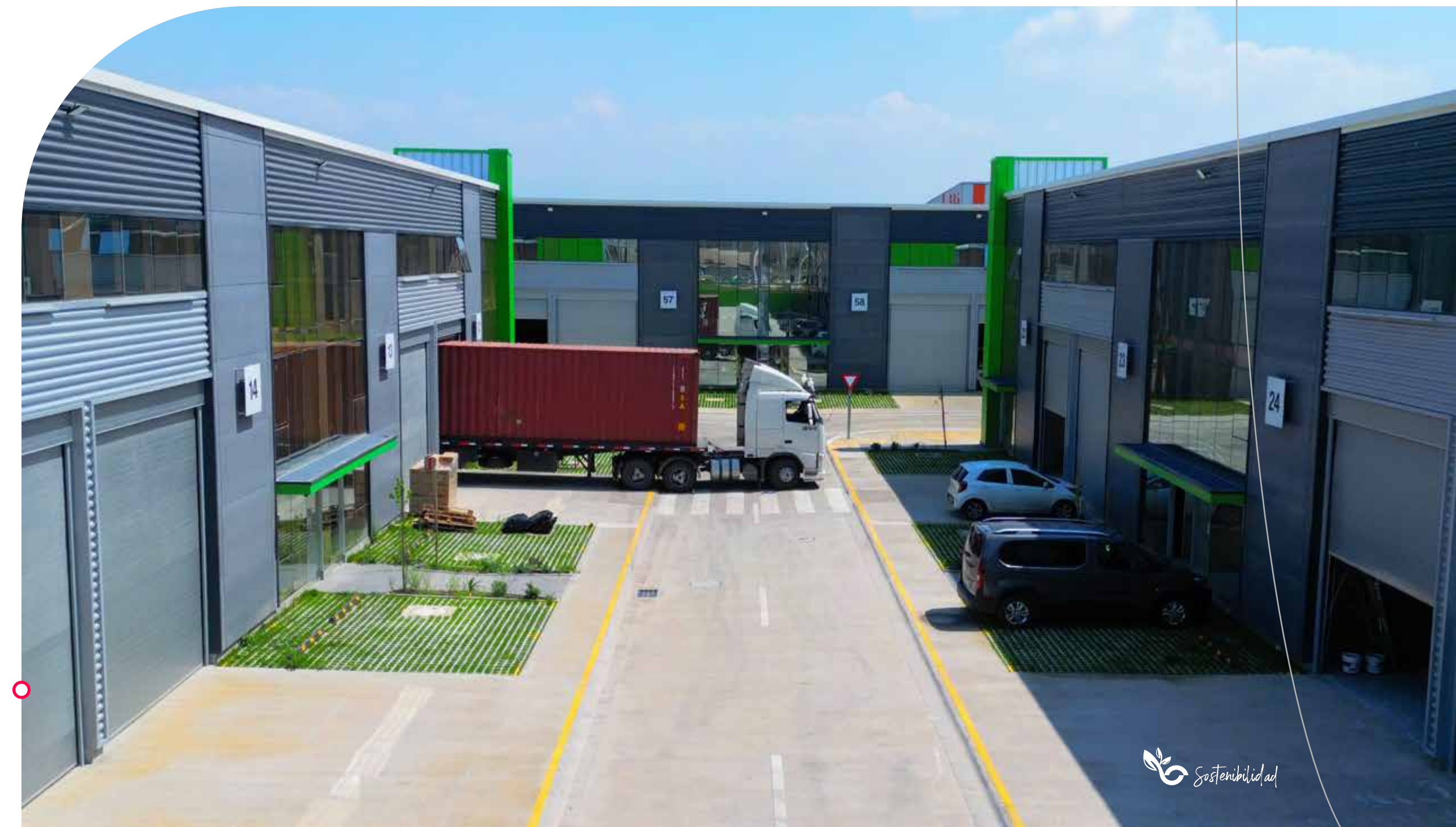
Work Center Miraflores Norte (Renta Industrial), Pudahuel - Santiago, RM, Chile.
