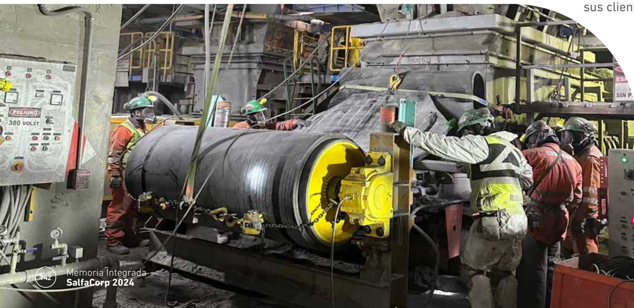
Codelco División Andina, Mantención Correas Transportadoras, Los Andes, Región de Valparaíso, Chile.
