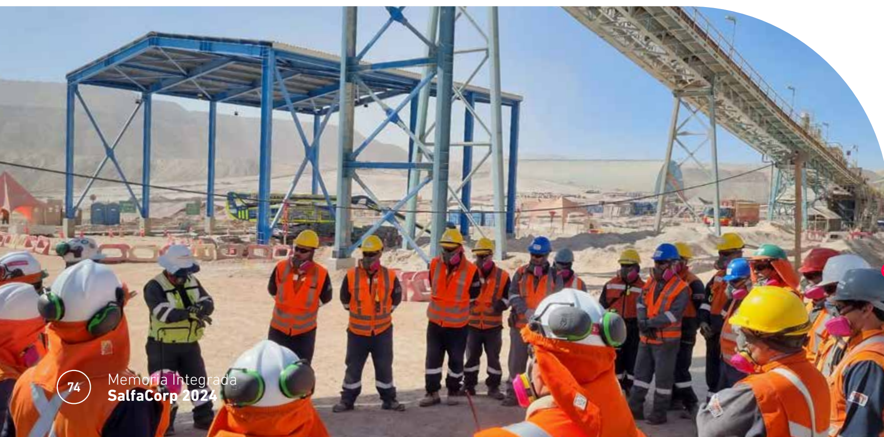
BHP - Minera Escondida, Contrato CC-02 Construcción y Montaje Electromecánico Proyecto Escondida Full SaL (EFS), Antofagasta, Región de Antofagasta, Chile.
