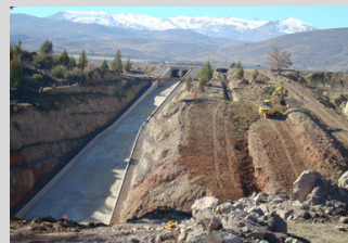
Grandes Movimientos de Tierra
