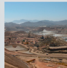
MOVIMIENTOS DE TIERRA
