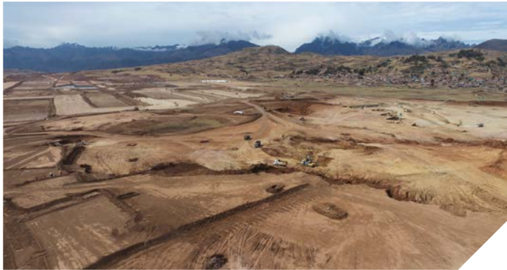
Movimiento de Tierras Aeropuerto Chinchero (Cusco)
