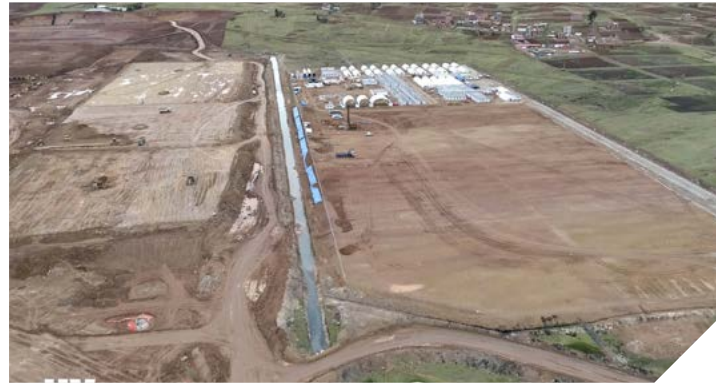
Obras Principales (Lado Aire/Lado Tierra) Aeropuerto Chinchero (Cusco)
