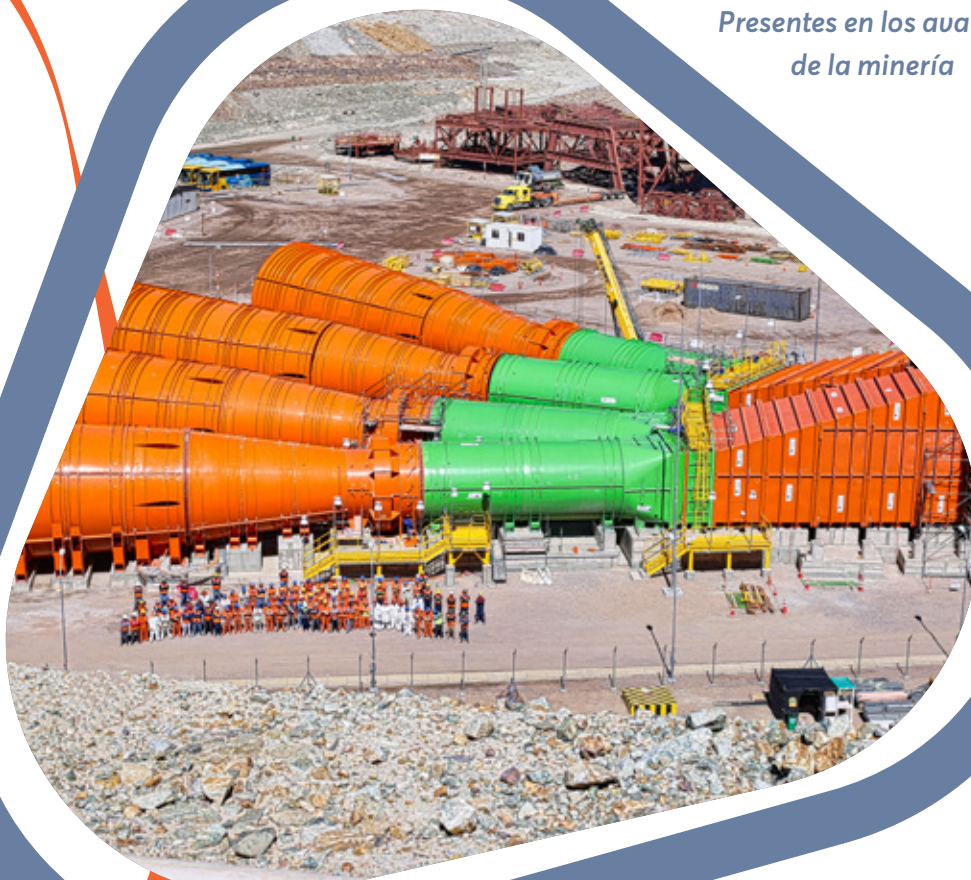
Codelco Chuquicamata Subterránea, Obras Cíviles y Montaje de Ventiladores Principales, II Región, Calama.
