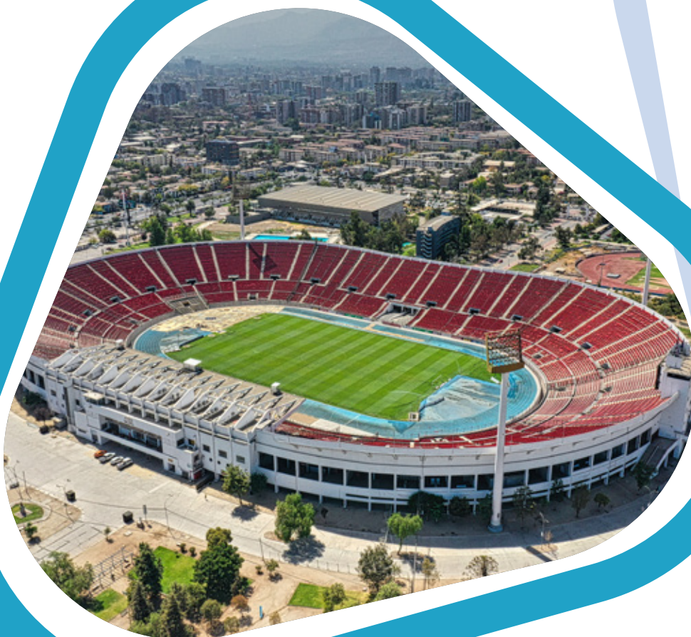
Construcción Obra Inicial Estadio Nacional RM, Ñuñoa - Santiago.
